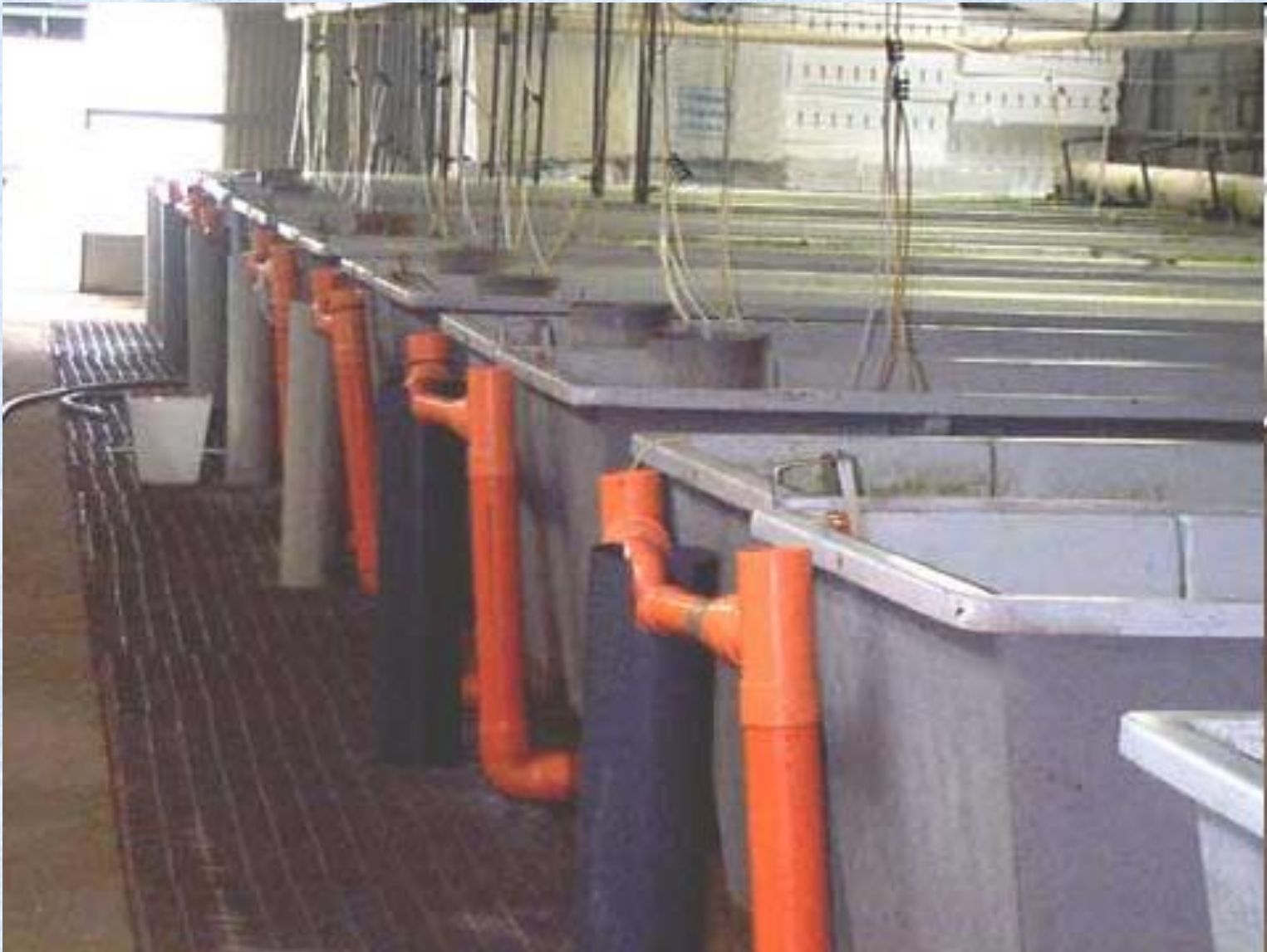
Pavimento grigliato lungo le vasche del reparto avannotteria.
